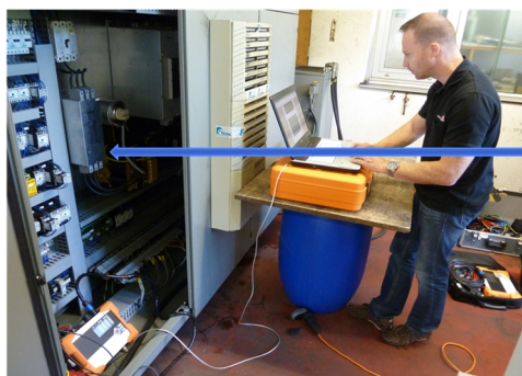
Meting met de PQ Box 200 om het effect te bekijken
